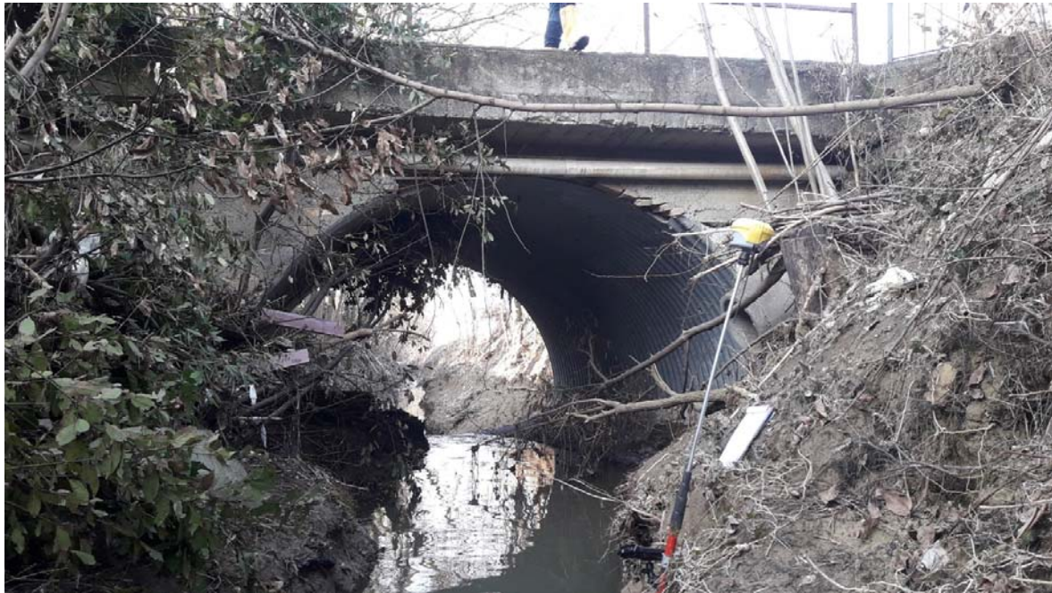
Foto 11 – Sezione 9 del rilievo topografico - Dissesto zona G
